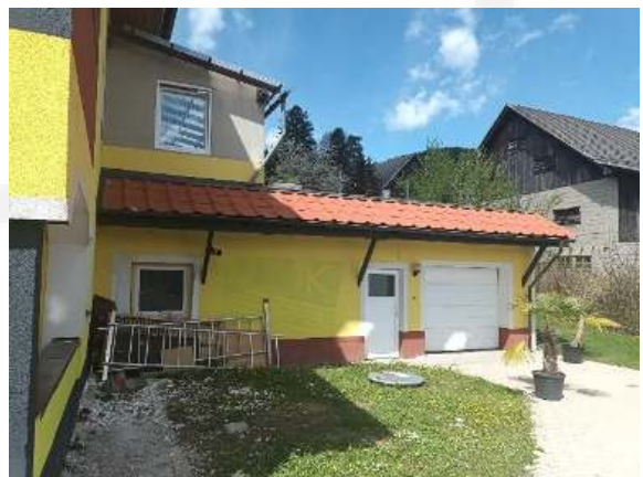
Südansicht Garage Eingang
