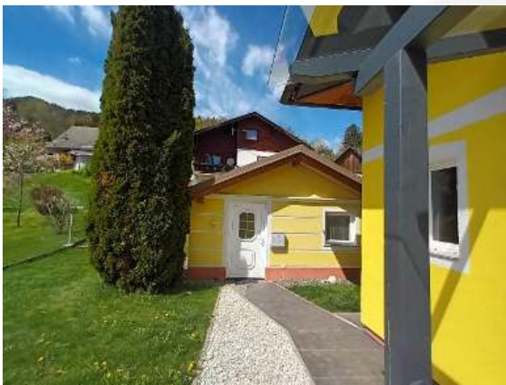
Ansicht Eingang Erdgeschoss Richtung Norden
