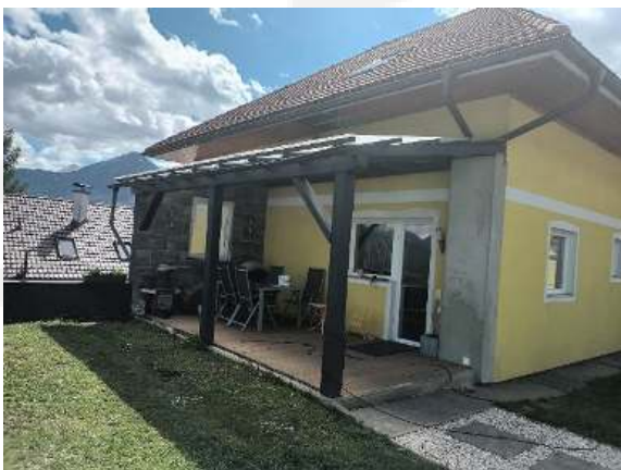
Ansicht Ost, Terrasse von der Küche
