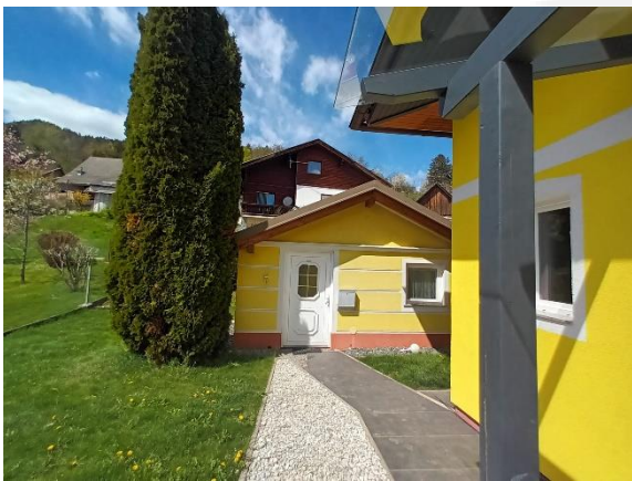
Ansicht Eingang Erdgeschoss Richtung Norden
