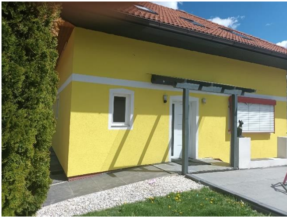
Eingang Erdgeschoss (West)
